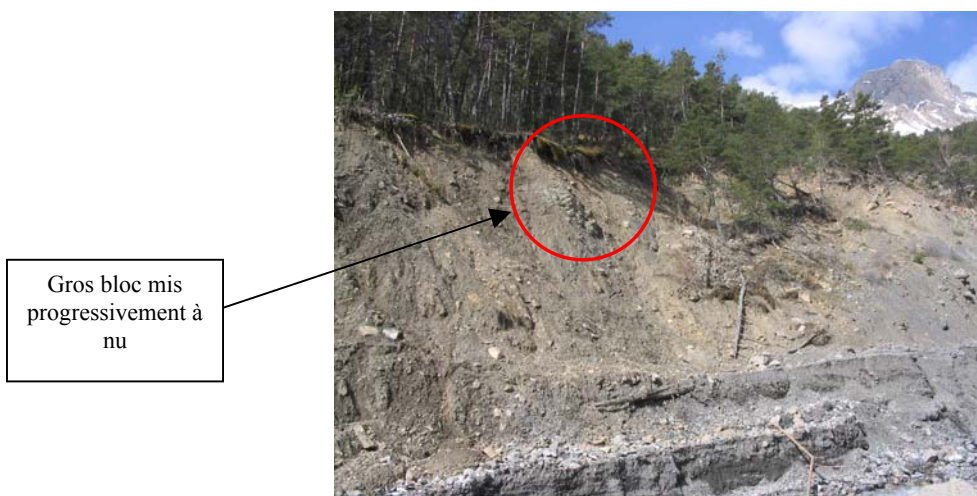
Photo 1 : Situation de l'érosion dans les gorges à l'amont du barrage 3
