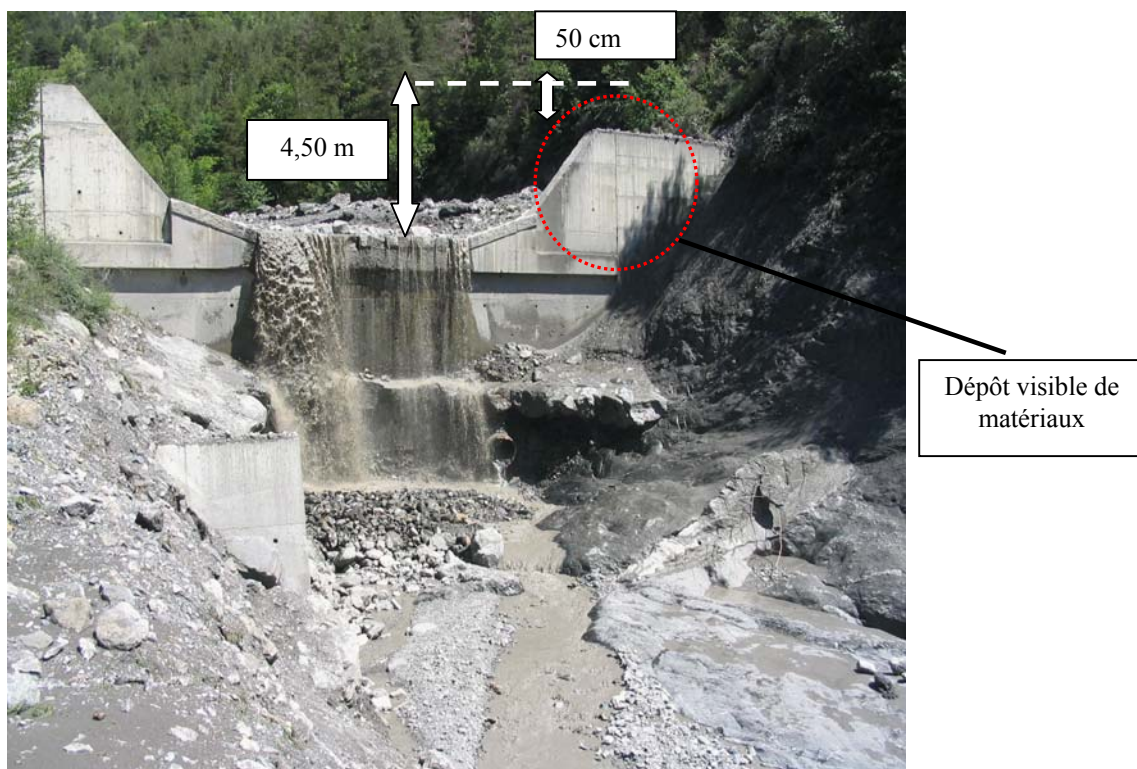
Photo : Evaluation de la hauteur de lave au niveau du barrage B2
