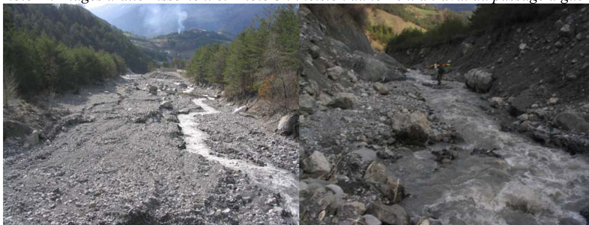
Photo 2 : Plages d'atterrissement et Photo 3 : incision du torrent à l'aval du passage à gué
